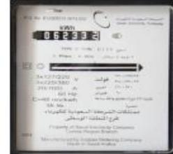
**الشكل ١٤** عداد كهرباء يقيس كمية الطاقة الكهربائية المستهلكة بوحدة كيلوواط. ساعة. تعرف عداد الكهرباء المرتّب في منزلك.
