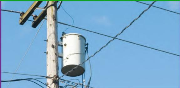
هناك أدوات تُسمى المحولات تستعمل المغناطيسية لخفض التيار الكهربائي إلى قدرٍ مناسبٍ ليستخدم في المنازل.
