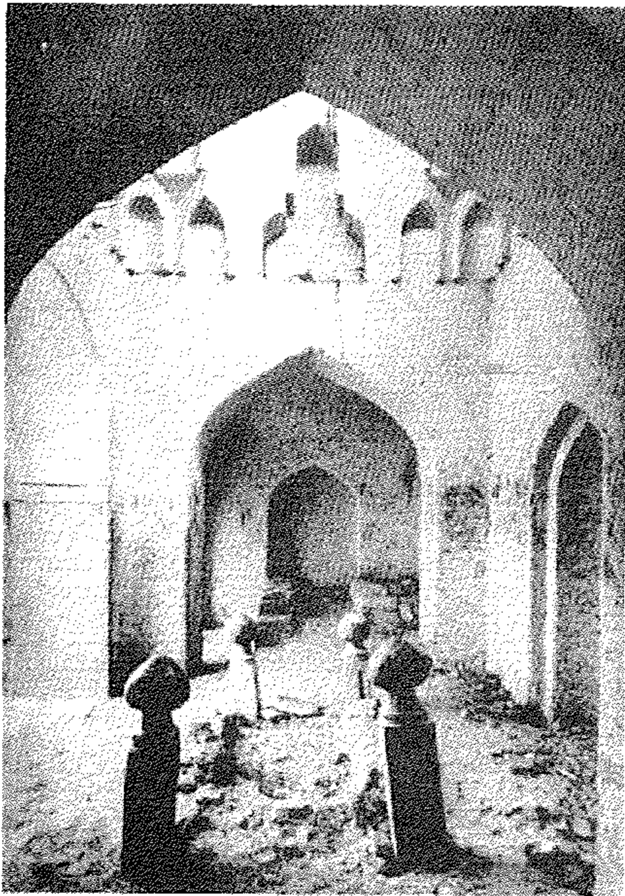
و - الحرم ، جهة الشمال الشرقي .
