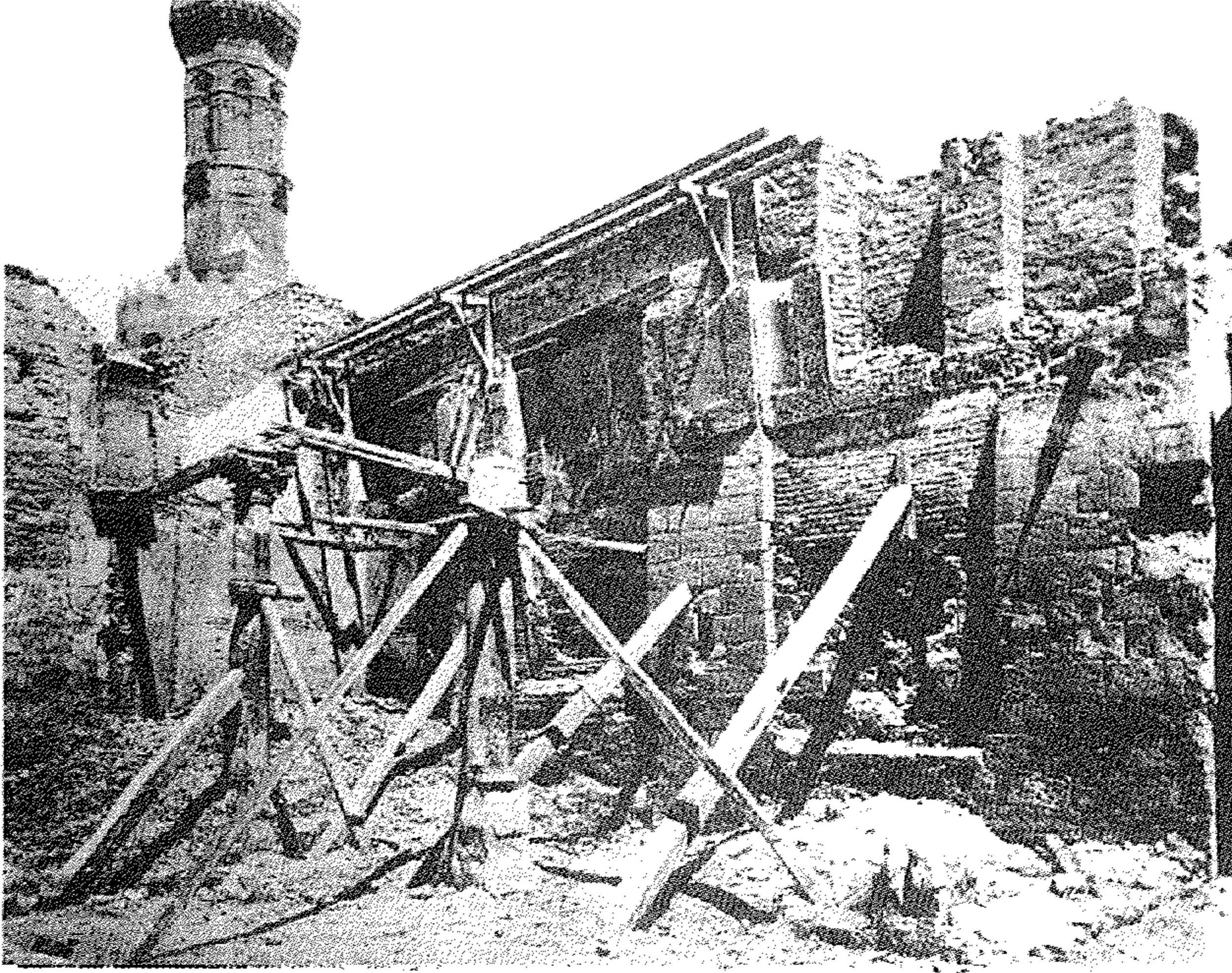
أ - الداخل : الركن الشمالي أثناء الترميم .
