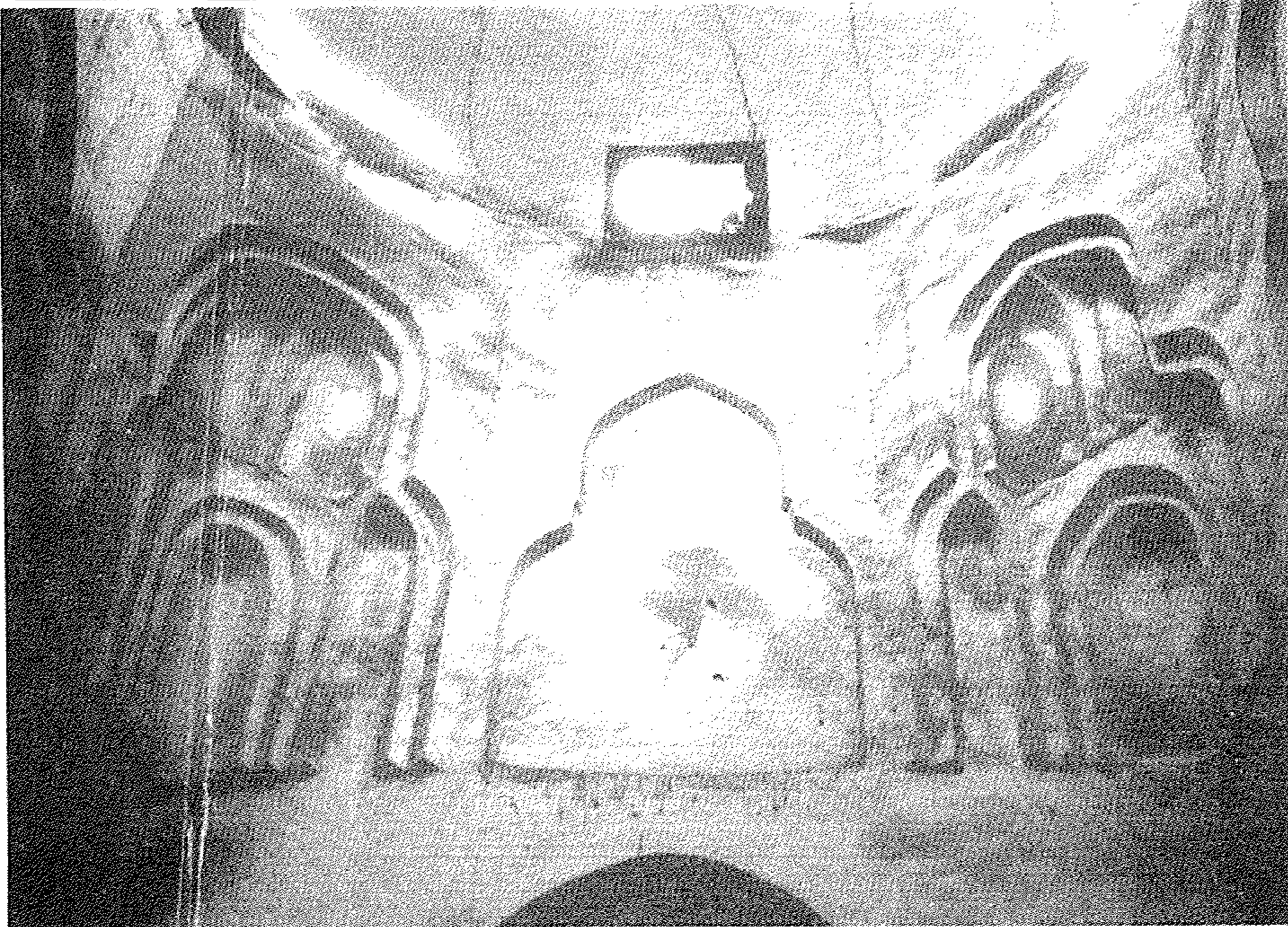
( شكل رقم ١٣١ ) القاهرة القديمة : كنيسة أبو سيفين ، مقرنصات (منطقة انتقال) مصلى القديس جورج .
