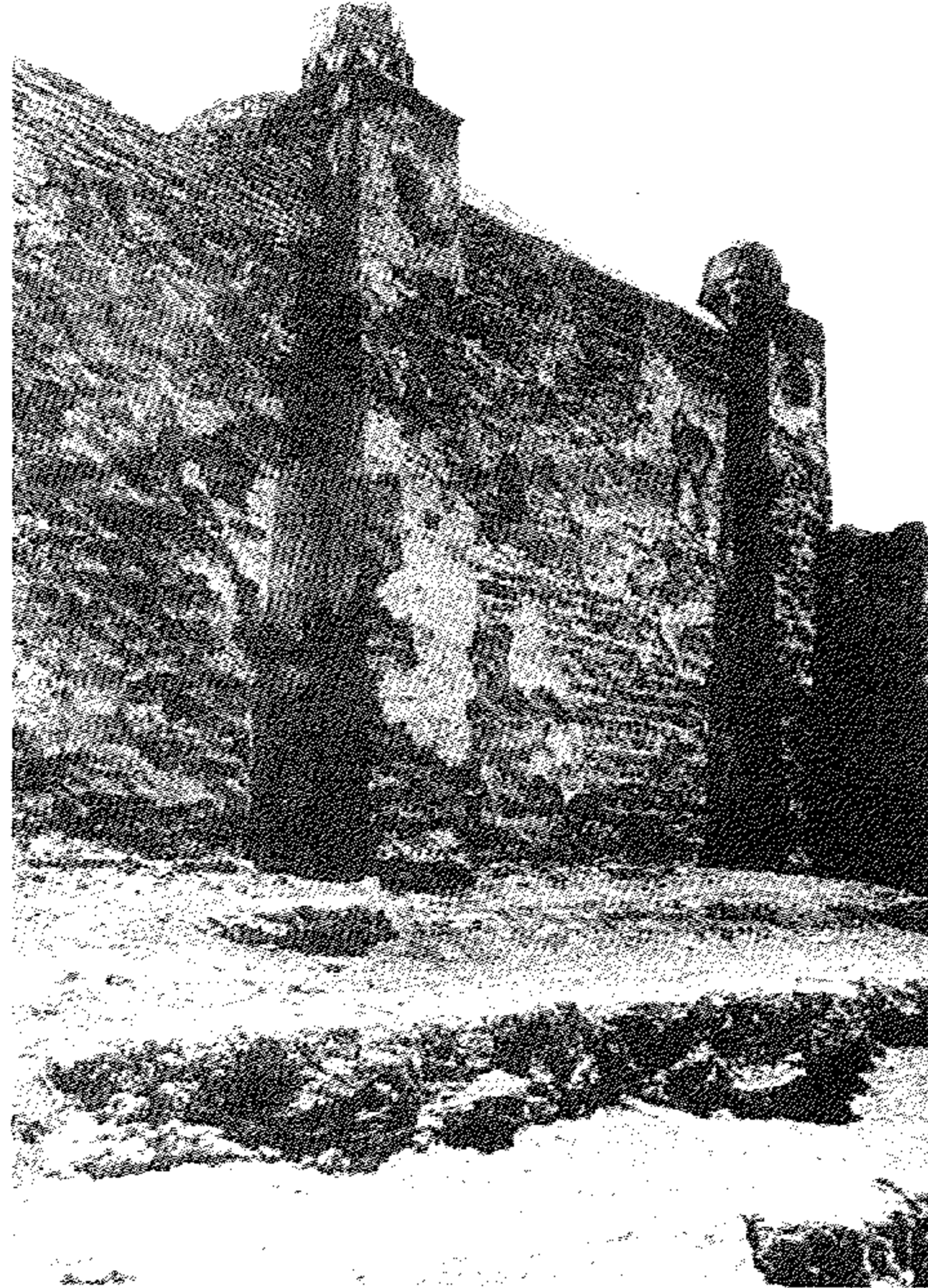
جـ - الجانب الجنوبي الغربي ، وتشاهد الدعامات المتوجة بمصليات (خلوات أو جواسق) ذات قباب صغيرة .
