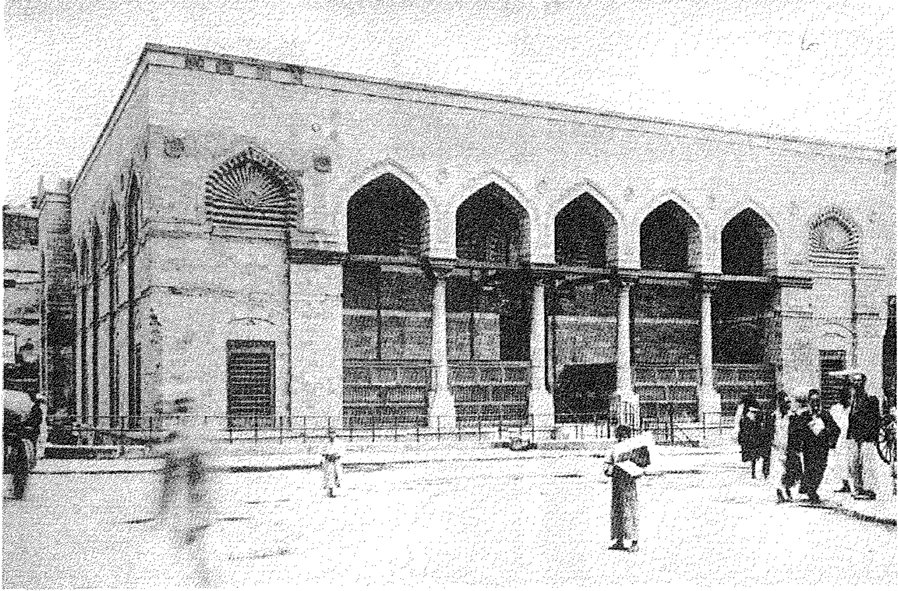
أ - الواجهة الشمالية الغربية بعد الترميم .
