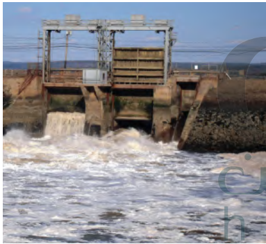
الشكل ١٠ محطة طاقة تعتمد على طاقة المد والجزر في توليد الطاقة الكهربائية.
