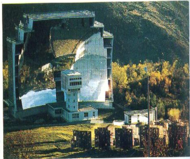
تعكس المرآيا المقعرة أشعة الشمس في بؤرة داخل هذا الفرن الشمسي جنوب فرنسا . وتصل درجة حرارة هذا الفرن إلى ما يزيد عن 4000^{\circ}\text{C} عند بؤرة المرآة .
