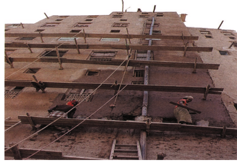
أشخاص يعملون في ترميم المباني الطينية
