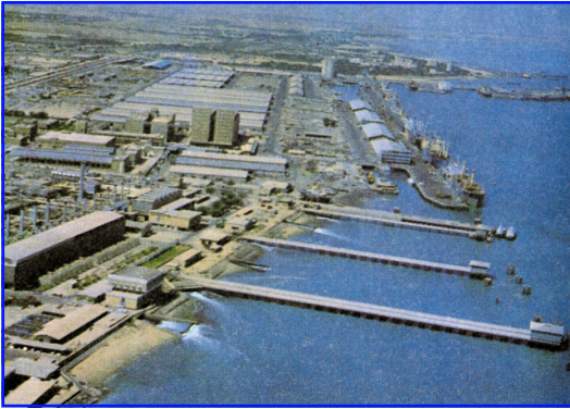
شكل (٦٥) محطة تحلية مياه البحار
