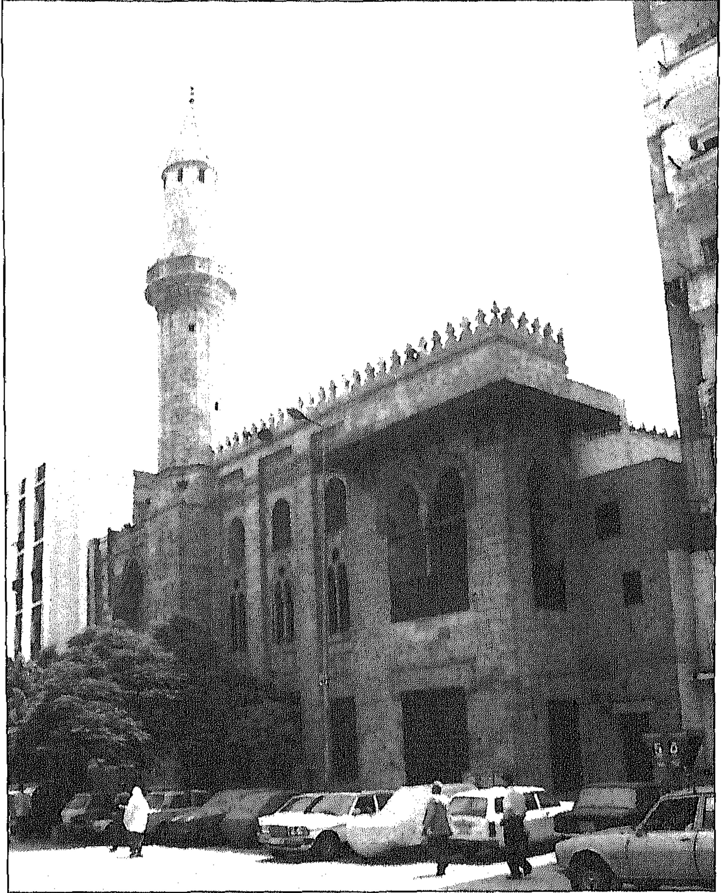
شكل [٧٣] المدرسة الفخرية الواجهة الرئيسية
