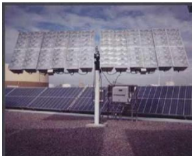
شكل (3) منظومات تتبع الشمس Sun Tracking
