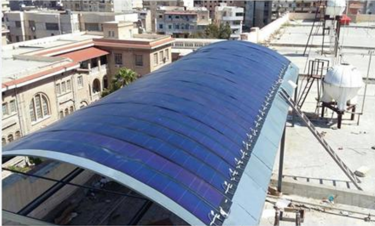
مظلة شمسية بأعلى سطح مبنى الإدارة
