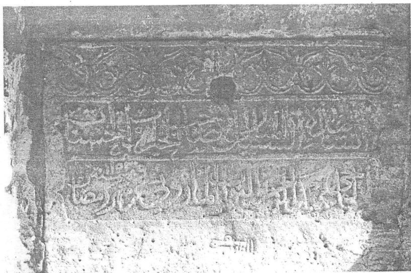
( لوحة رقم ٣٠ ) النقش الكتابي التذكاري أسفل شباك سبيل الميزوني برشيد ١١٥٣هـ / ١٧٤٠م.
