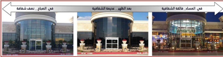
الشكل (13): زجاج فوتوكرومي في منشأة تعليمية في كيلر، تكساس، الولايات المتحدة الأمريكية. (26)
