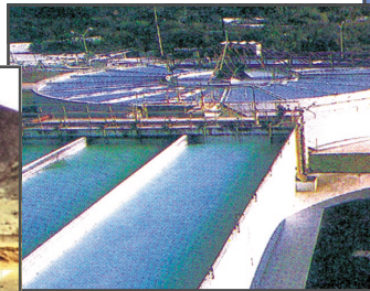
شكل (٢) محطة معالجة مياه صرف صحي
