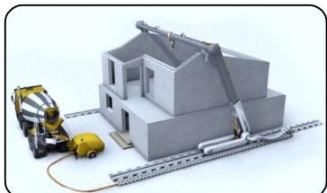
0 نطاق ... واسع : تستخدم لإنشاء مبانٍ كاملة كمنازل الصغيرة وذلك باستخدام الخرسانة أو المواد البلاستيكية أو المشتقات الأخرى.
