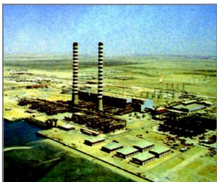
شكل ( ٤ ) محطة تحلية مياه.
