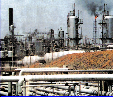
شكل ( ٤ ) مصفاة نفط .
