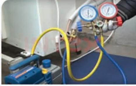
٢ صل فتحة ساعة الضغط المنخفض بالخرطوم الأزرق وصل الطرف الآخر بجهاز التبريد.
