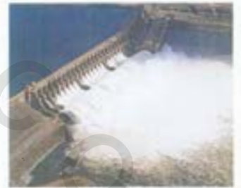
عندما تسقط المياه من فوق السد، تتحول طاقة الوضع إلى طاقة حركية. واستخدام هذه الطاقة لتوليد الكهرباء يسمى الطاقة الكهرومائية.
