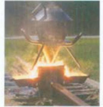
الحديد المنصهر الذي تكوّن في تفاعل الثيرمايت يصطدم بقالب بين نهايات قضيبين من قضبان السكك الحديدية. وعندما يبرد، تلتحم القضبان مع بعضها.
