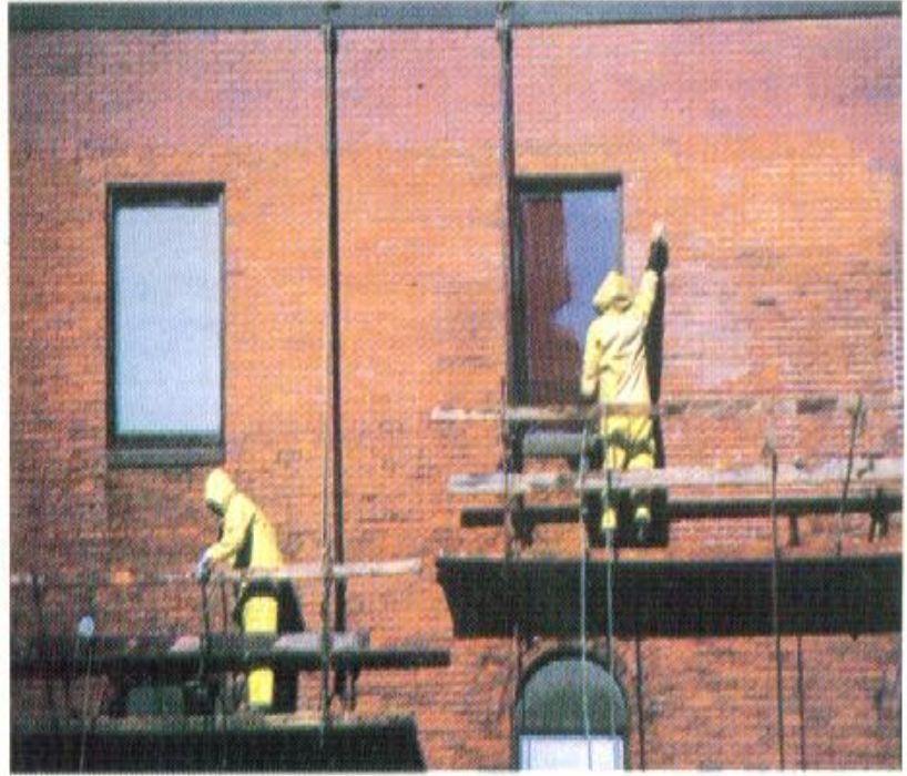
يستخدم عمال نظافة الشباهيك أنظمة البكرات لرفع وخفض السقالات .
