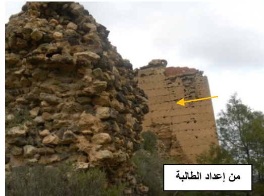
الصورة رقم (10): زوال الملاط الرابط للحجارة في أساسات سور تاونت وظهور شقوق (عمودية) على مستوى الجدران والأبراج (البرج الشرقي نموذجاً).
