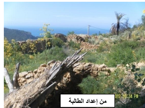
الصورة رقم (12): انهيار كلي وجزئي للأسقف والعناصر الحاملة لبعض المنازل بقرية سيدي المخفي ونمو كثيف للنباتات بين جدرانها.
