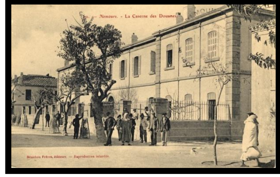
الصورة رقم (75): صورة قديمة لتكنة الجمارك (استبدلت بأخرى حديثة). عن: إدارة ميناء الغزوات.
