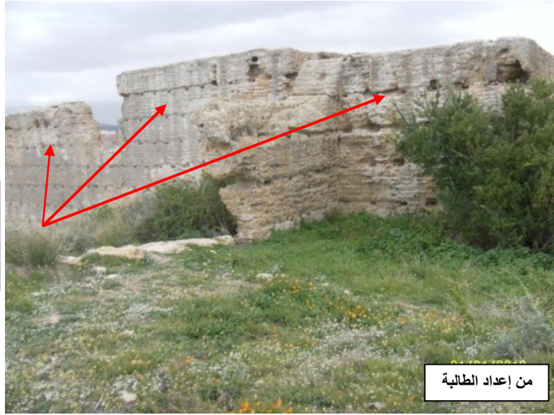
الصورة رقم (09): ظهور طبقة بيضاء (مترسبة) على سطح جدران حصن تاونت بعد سقوط الأمطار.
