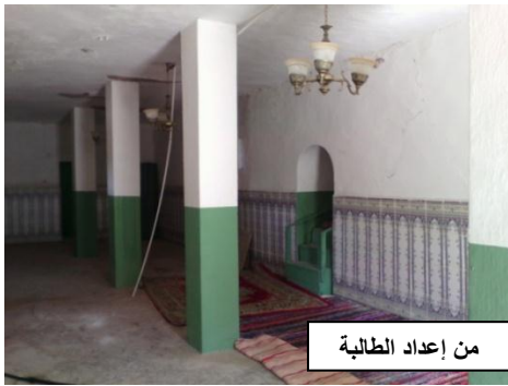
الصورة رقم (48): إضافة سقف وأعمدة إسمنتية وتكسية الجدران الداخلية بطبقة من الإسمنت والزليج.
