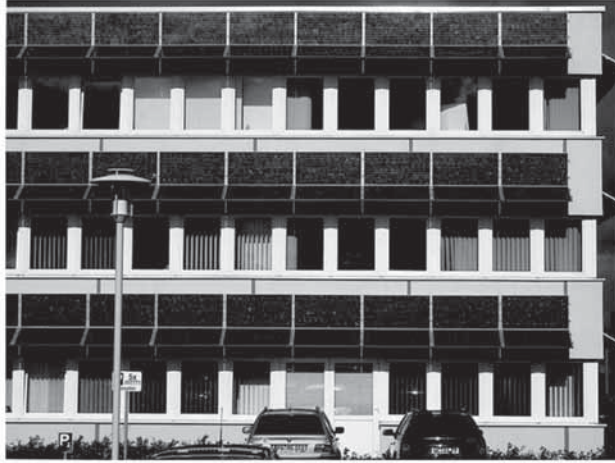
الشكل (10-13): واجهة بمنظومات فولتضوئية كحواجب للنوافذ للتقليل من حمل مكيف الهواء وكزخارف (شوهدت في سولارورلد (Solarworld) في مدينة فريبورغ، ساكسوني (Saxony)).
