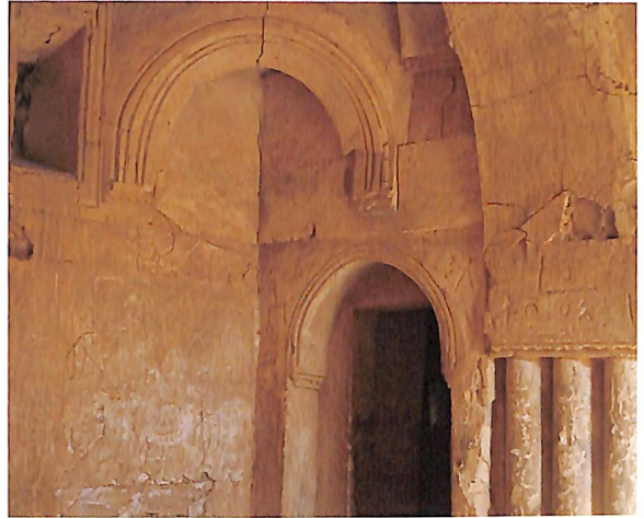
منظر لإحدى القاعات الداخلية في قصر الخزانة، البيادية.
