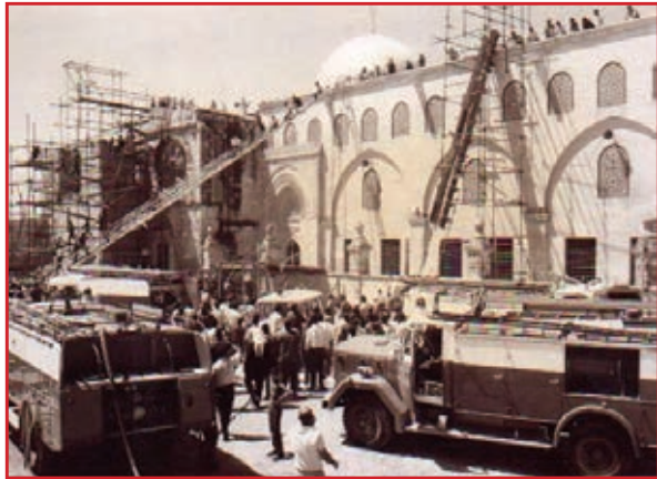
شكل ٤-١٢ حريق المسجد الأقصى عام ١٣٨٩هـ/١٩٦٩م
