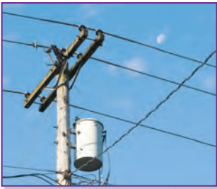
هناك أدوات تُسمى المحولات تستعمل المغناطيسية لخفض التيار الكهربائي إلى قدرٍ مناسبٍ يُستخدم في المنازل.
