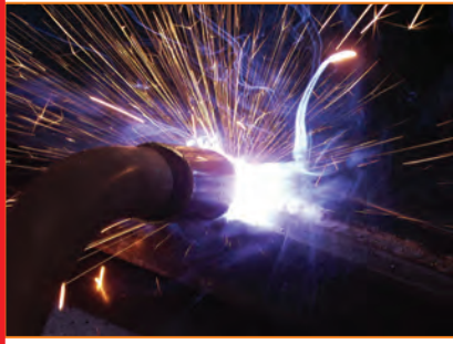
تطلق التفاعلات الطاردة للطاقة طاقة حرارية، مثل حرارة هذا المشعل الكهربائي الذي يُستخدم في اللحام.
